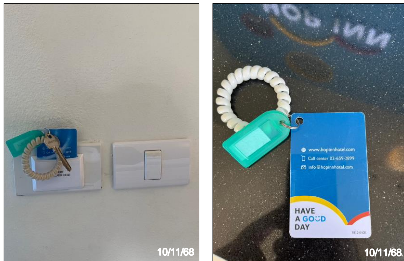
รูปภาพที่ 2.18 ระบบคีย์การ์ด ควบคุมการเปิด-ปิด ภายในห้องพัก
